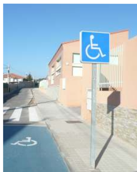
La comunidad educativa del "San Martín de Tours" cuenta con una nueva acera, 2 plazas de aparcamiento para discapacitados y un acceso más cómodo por el adoquinado de los alcorques de los árboles que ensanchan la acera existente.
