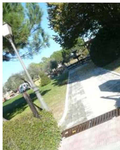
Pavimentación de los accesos en el parque de La Bola para facilitar la entrada a este pulmón verde, el tránsito de bicicletas o carricoches y evitar que la lluvia saque las tierras a la avenida Félix Rodríguez de la Fuente.
