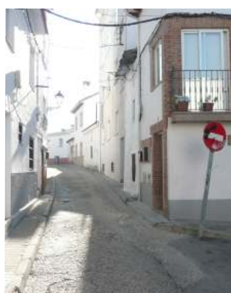
Próximo objetivo, calle Lanchas: Entre las próximas actuaciones que se van a realizar está la renovación del pavimento de la calle Lanchas, una pequeña vía paralela a Enrique Capdevila que va ser mejora en los próximos meses.
