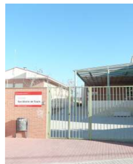
En este año la Comunidad de Madrid completará el colegio San Martín de Tours, con dos nuevas aulas necesarias para que los alumnos de primaria puedan finalizar el ciclo. El presupuesto de esta actuación y autorizada es de 167.770€
