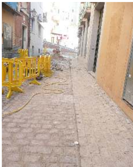
La calle Fraguas ya no temerá a las lluvias, gracias a la remodelación en la que se ha reutilizando el adoquín existente, la acera es ahora más ancha, al igual que las entradas de alcantarillado para evitar las balsas de agua cuando llueve.
