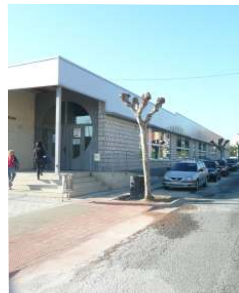
La piscina climatizada cuenta con 12 nuevas plazas de aparcamiento, que descongestionan la calle Salamanca y facilitan el acceso al centro deportivo. También se han rebajado las aceras en la entrada y pasos de peatones cercanos.
