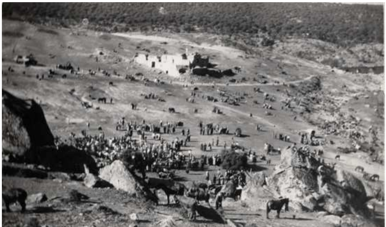
La Romería en el año 1954, antes de construirse el Pantano de San Juan
