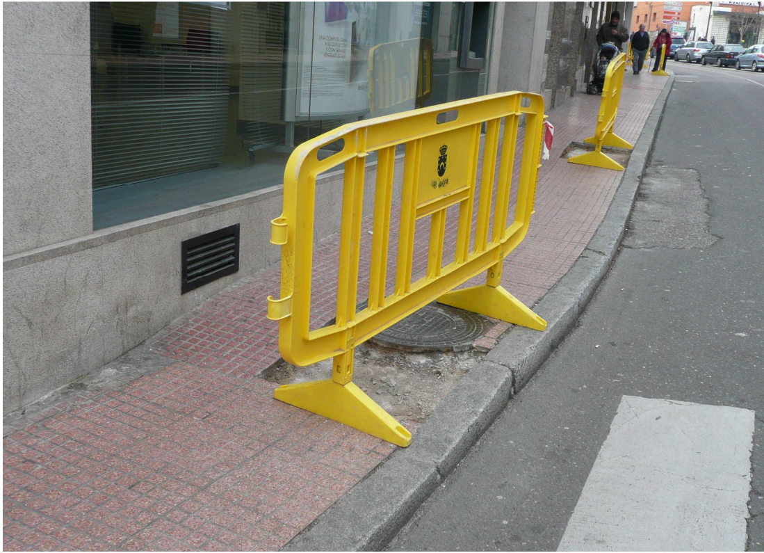
Imagen de las obras de reparación de aceras que se están efectuando en las calles Corredera Alta y Corredera Baja.
