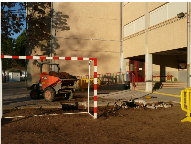
Imagen de las obras, para ampliar el porche del edificio norte en el colegio Virgen de la Nueva
