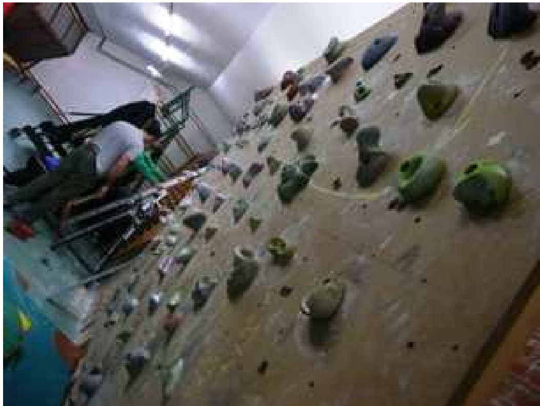
Los miembros del club, realizando trabajos de montaje durante el pasado mes de marzo.
