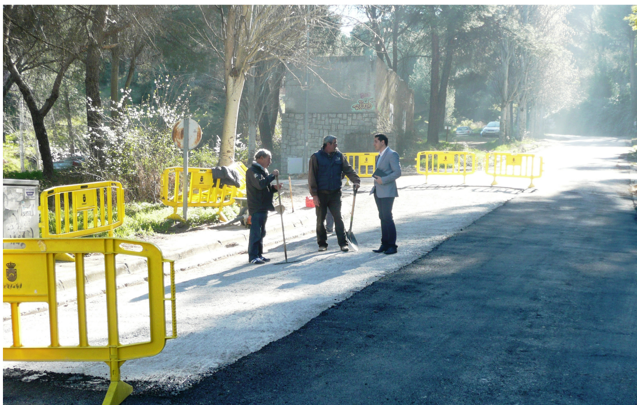
El concejal de Servicios e Infraestructuras, Luis Haro, ha supervisado los trabajos de asfaltado esta misma mañana, en la avenida del Galeón.
