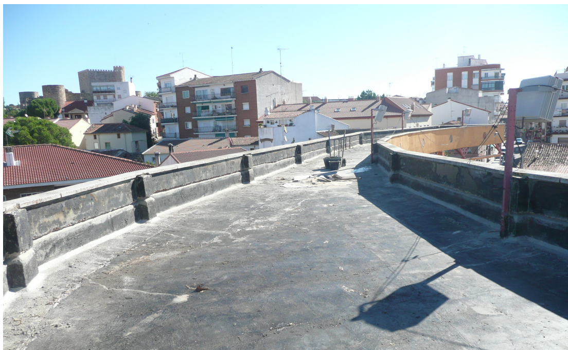
Imagen del estado actual del techado de la Plaza, tras la retirada de la antigua tela asfáltica.
