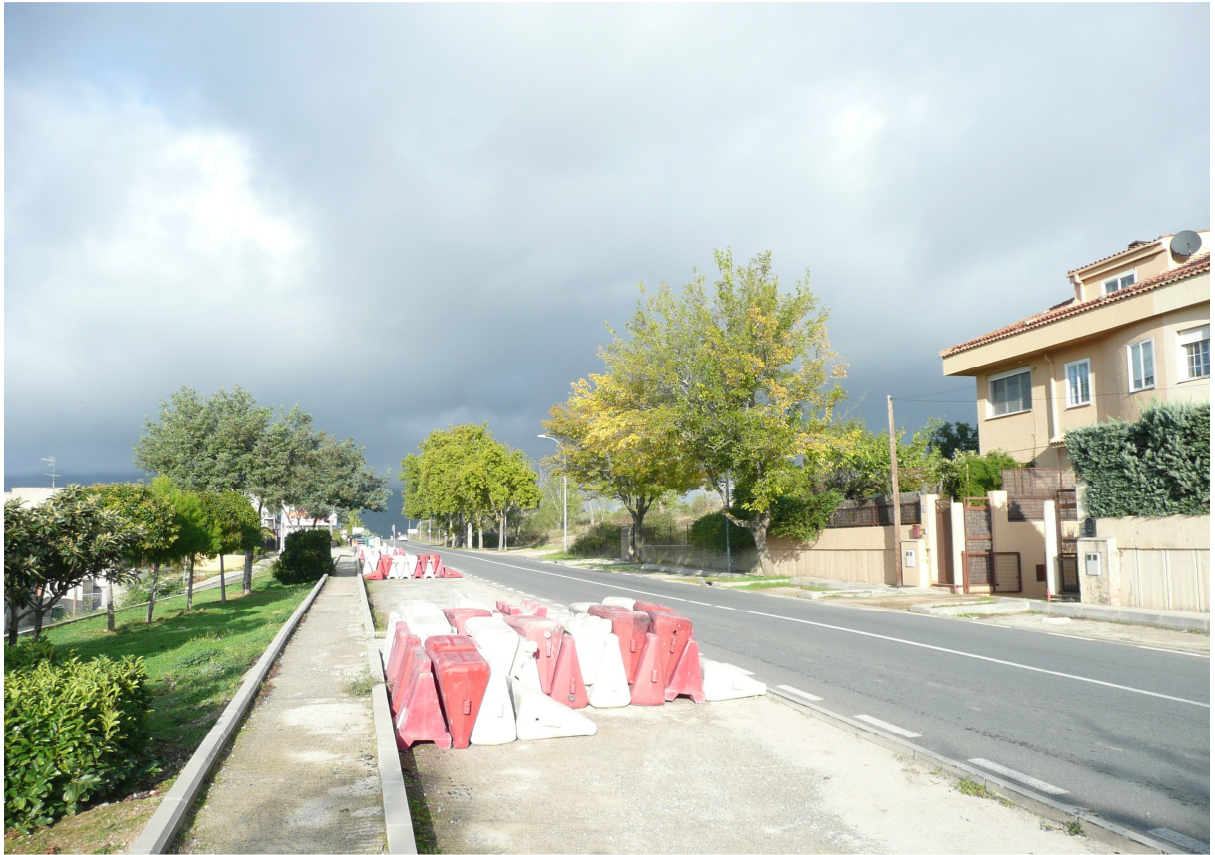
Estado actual de la carretera de Ávila.
