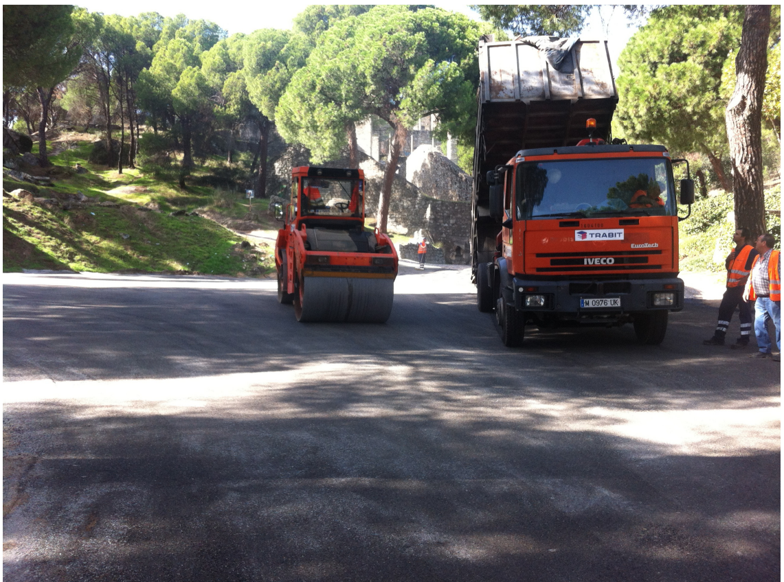
Zona de aparcamiento, tras el asfaltado utilizando zahorras naturales.
