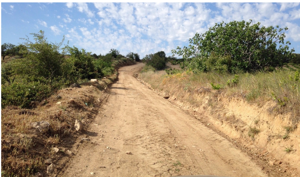
Imagen del Camino Viejo de Cadalso tras las obras de eliminación de baches, llenado de arcilla.
