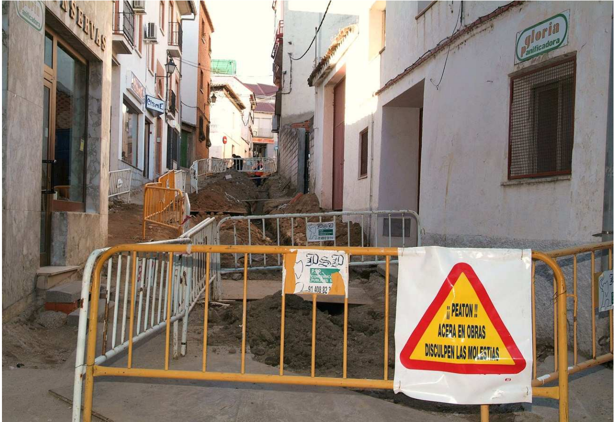
Imagen 01.- Estado de las obras de remodelación y mejora de la C/ Dr. Romero
