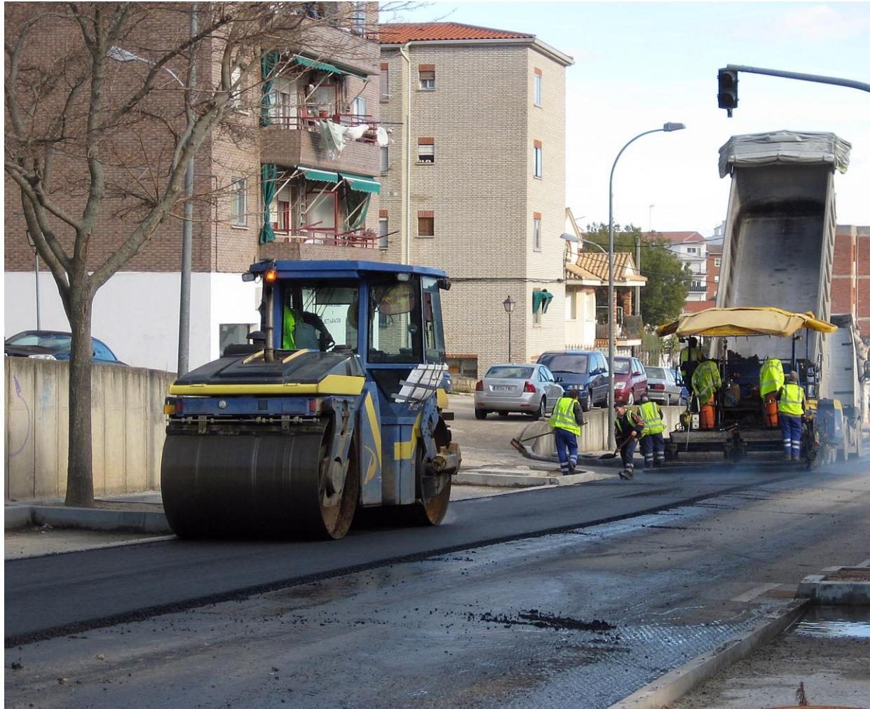
*Imagen 02.- Trabajos de asfaltado en la Ctra. de Ávila.*
