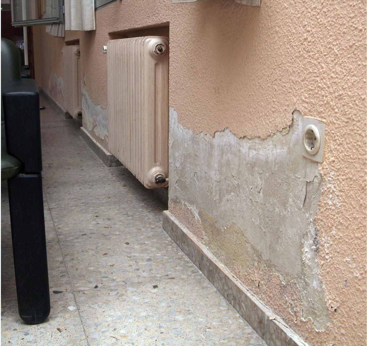
*Imagen 01.-Humedades en la pared y pintura levantada.*
