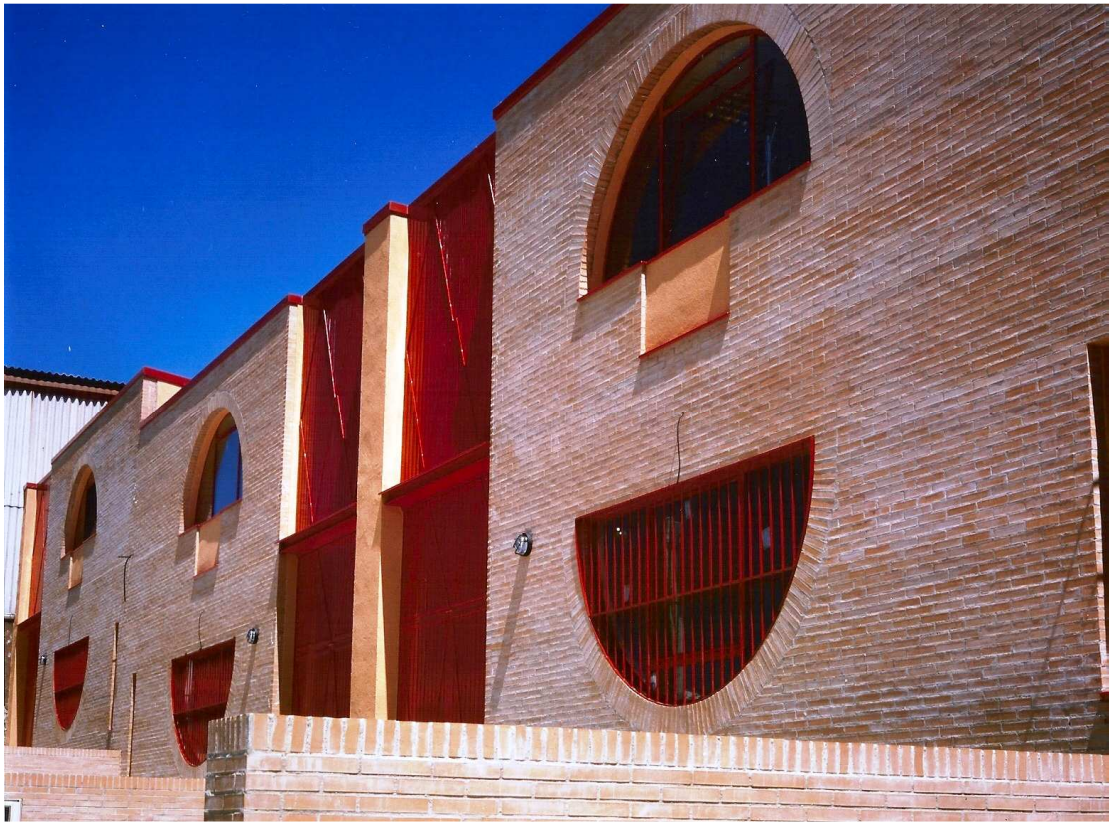
Imagen de las naves nido municipales situadas en la calle Alfareros.
